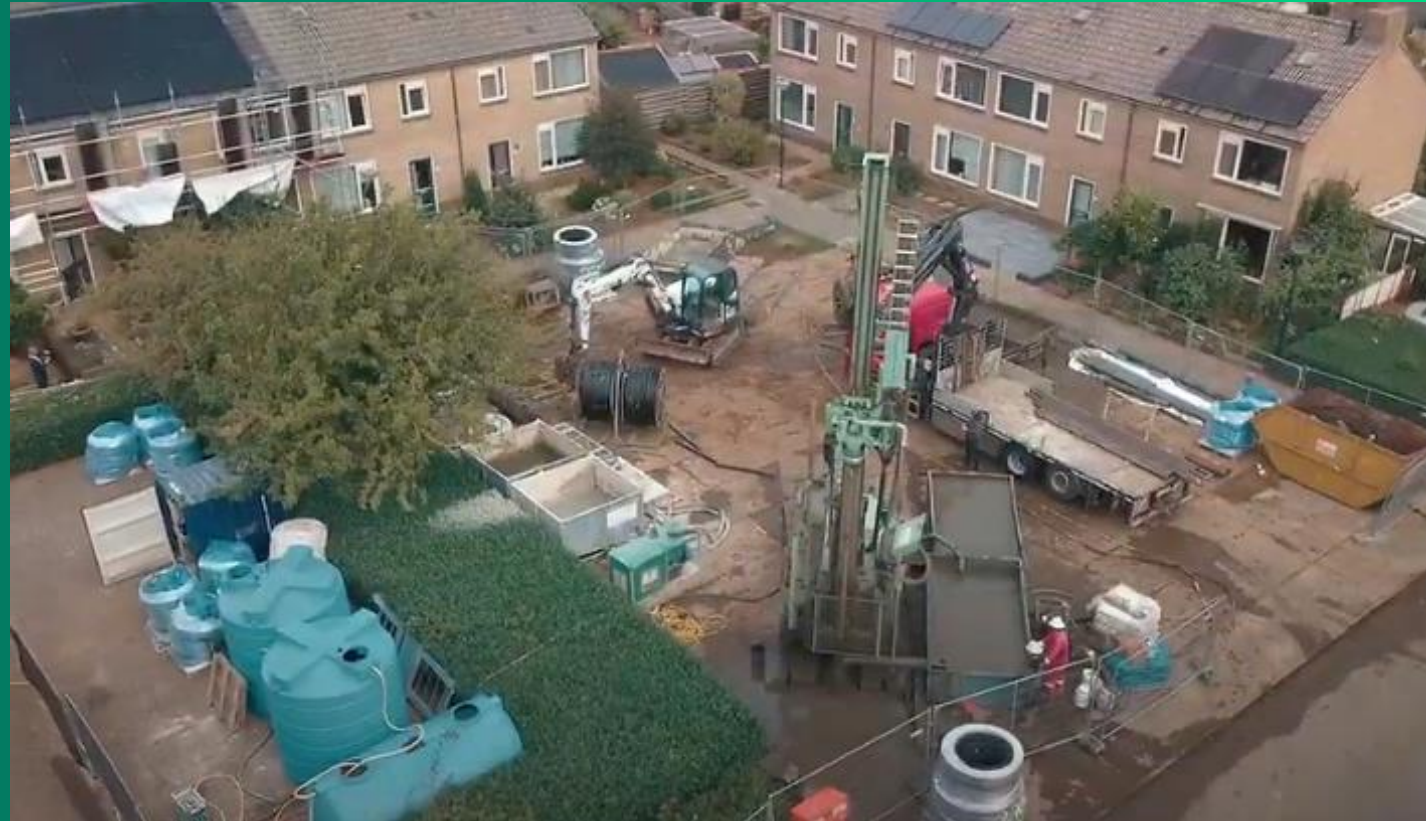
Project Wonion; warmtepompen voor 12 woningen, Terborg
